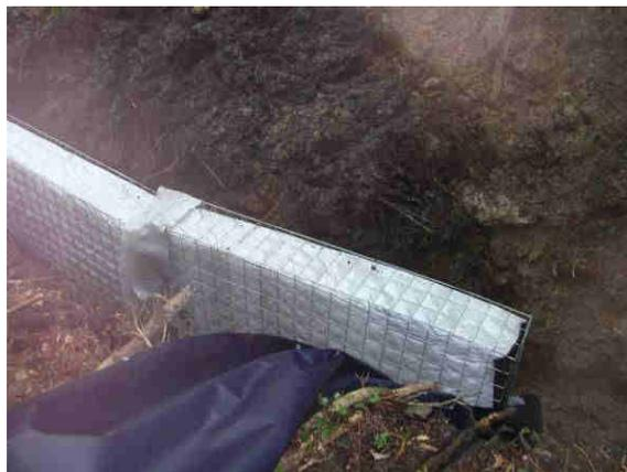
*Vista di un sistema di drenaggio in pannelli in fase di realizzazione.*
