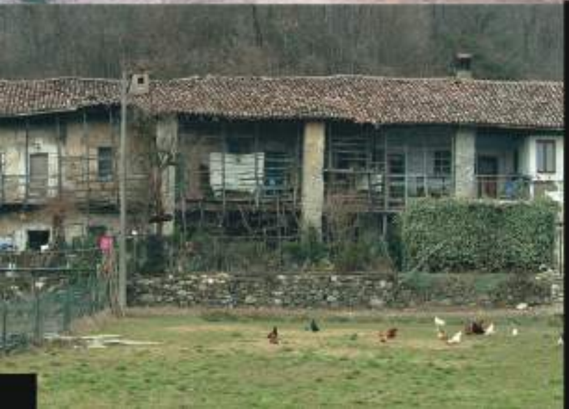
Alcuni esempi di edifici rurali presenti in valle.
