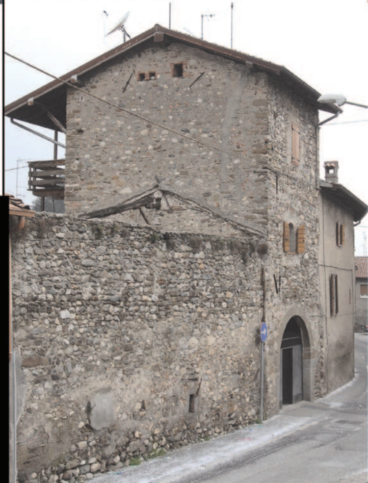
Sopra La casa-torre di Via Ferretti a Caprino Bergamasco.
